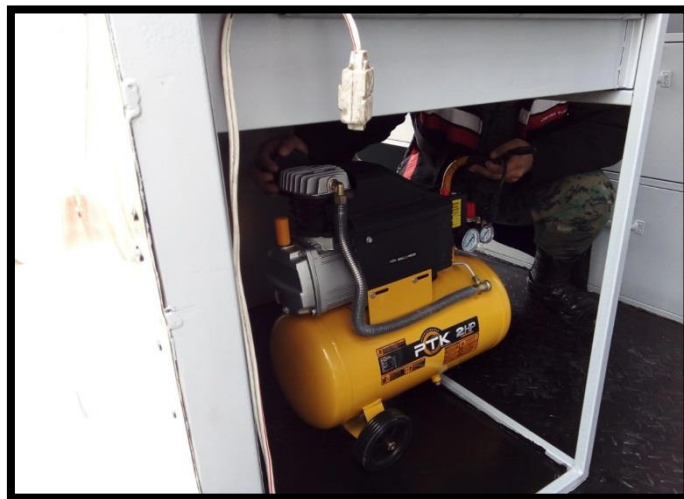
Figura 35 Instalación del compresor a la línea de aire.
