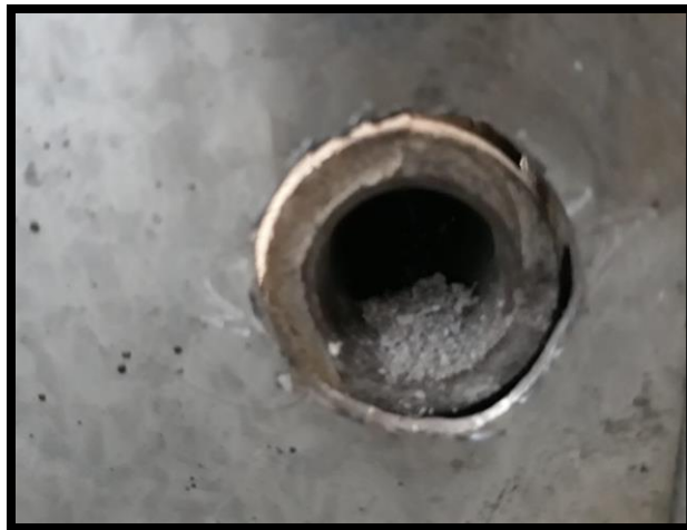
Figura 29 Corte circular en la base de la pared externa del taller
