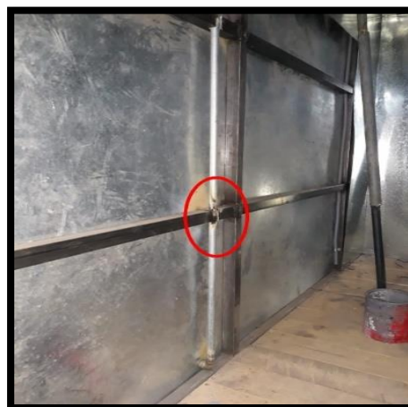
Figura 33 Inspección física y visual de las zonas vulnerables
