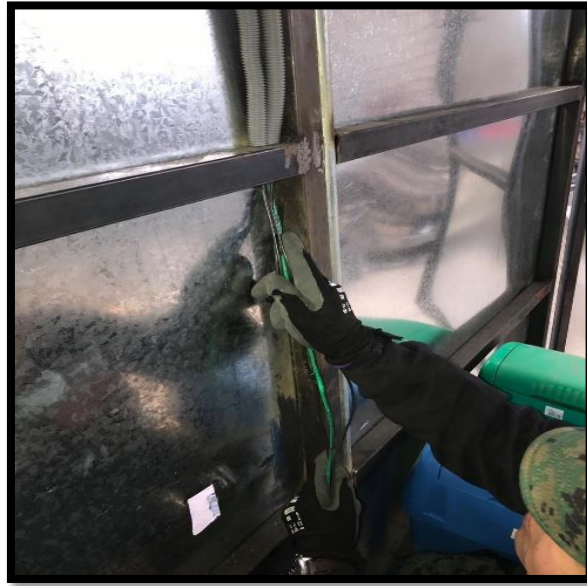
Figura 28 Inspeccion de la zona de trabajo
