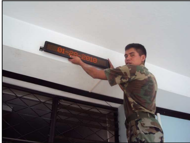
Fig. 3. 5 Colocación del letrero electrónico sobre los soportes
