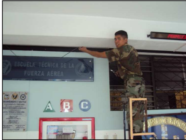
Fig. 3. 2 Colocación del cable para la comunicación serial
