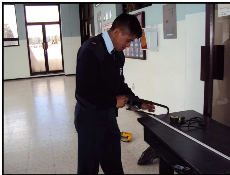
Fig. 3. 4 Corte de canaletas de protección para el cargador
