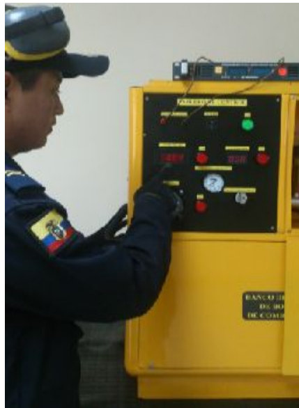
Figura 41. Prueba de funcionalidad general del módulo
