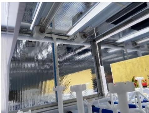
*Nota:* Paredes y techo de la zona de esterilización fueron forradas con papel vinilo metalizado, tipo espejo.
