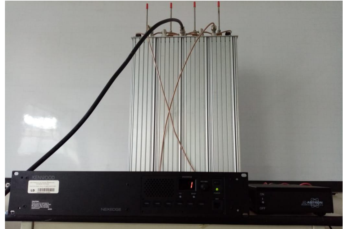
Instalación de equipos
