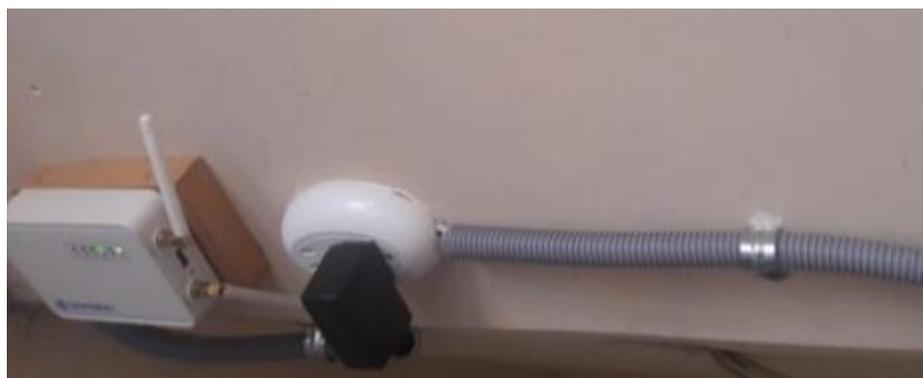
La Figura 46 muestra como quedó finalmente la conexión de los módulos que conforman el sistema de consumo de agua potable para el domicilio. La instalación del Gateway
