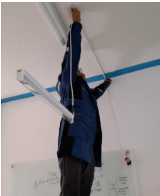
*Nota.* En la figura se muestra la instalación de las lámparas de radiación ultravioleta.
