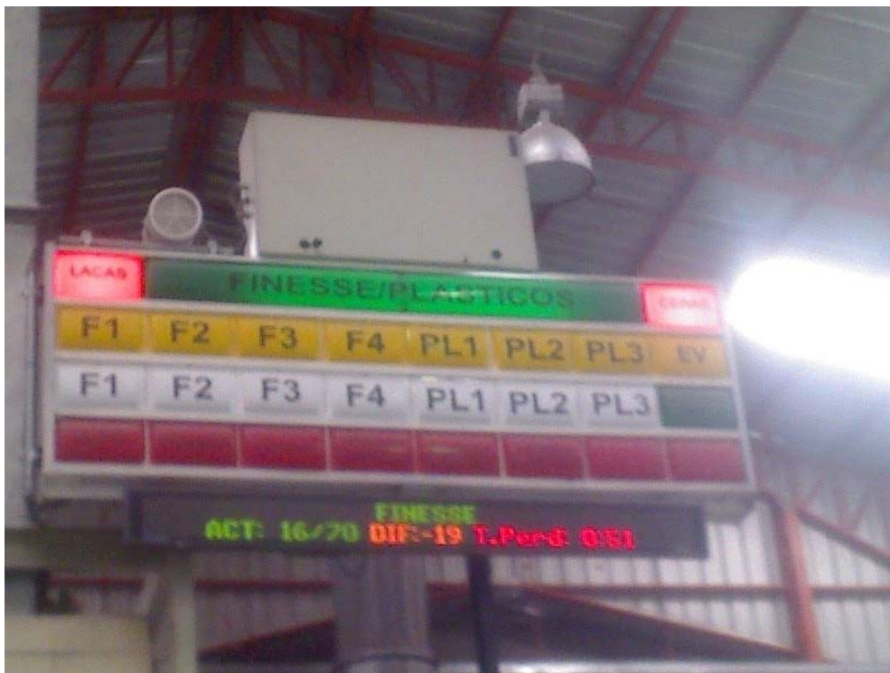
Figura. III. 14. Tablero de Sistema Andon
