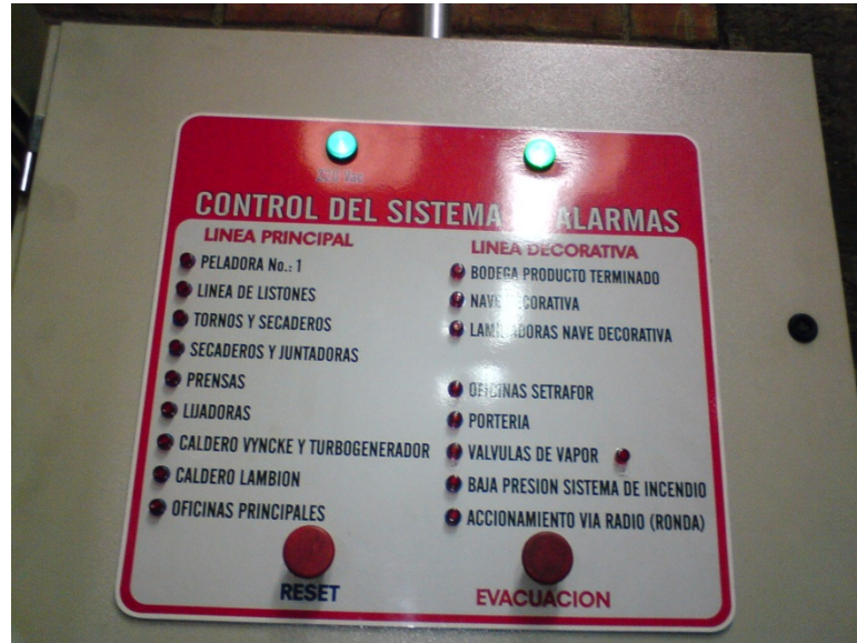
Figura. III. 4. Sistema de alarmas locales de Endesa-Botrosa
