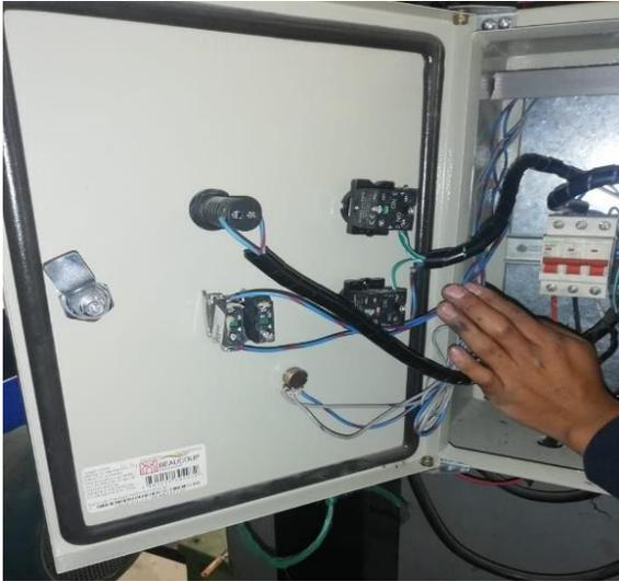
*Nota.* En la figura se muestra cómo se ubicaron los pulsadores, luz piloto y selector sobre la tapa del tablero de control.
