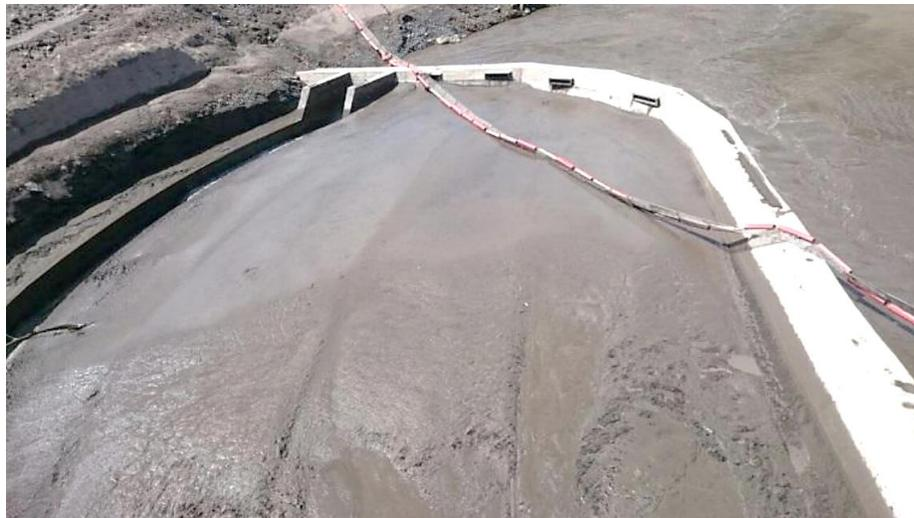
*Nota.* En la imagen se puede observar que el deflector de sedimentos se llena casi en su totalidad antes de la operación de lavado. Tomado de *Cálculo bidimensional de un deflector de arrastre de fondo para la presa de Manduriacu, Ecuador*, por Jácome Sánchez et al., 2015.
