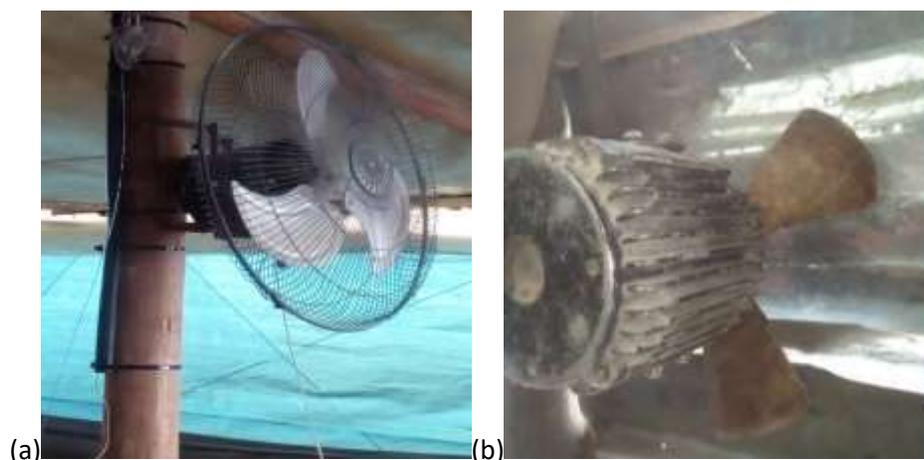
*Nota.* La figura(a) muestra la instalación del ventilador en el interior del galpón de pollos de engorde, el mismo que permite reducir la temperatura cuando sea necesario y la figura (b) muestra al ventilador que se encuentra en la parte frontal del galpón expulsando el calor y olor.
