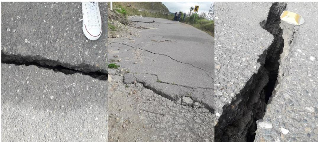
*Nota.* La imagen muestra las grietas que se produjeron por causa del deslizamiento, en el borde de una vía que se desprendió.
