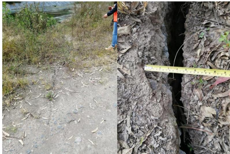
*Nota.* La imagen muestra las grietas que existe al costado de la piscina de oxidación principal que tiene un ancho de aproximadamente de 4 cm.
