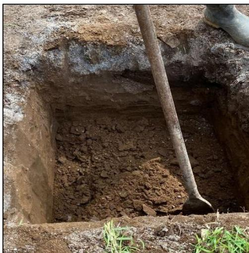
*Nota.* La imagen muestra la excavación del plinto de 0.60 m \* 0.60 m \* 0.50 m
