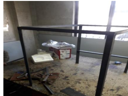
Estructura en construcción
