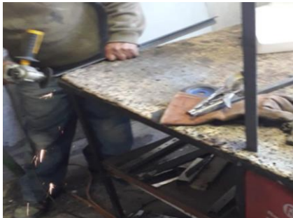
Construcción de la estructura
