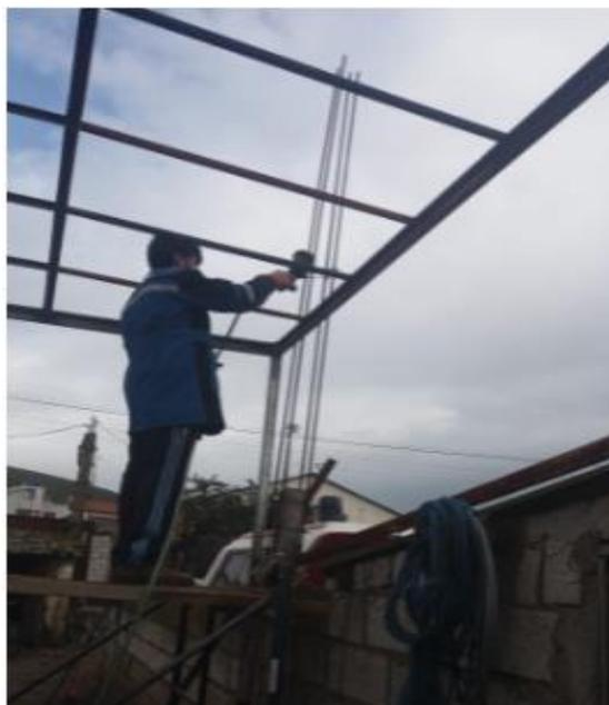
*Nota.* La figura muestra el proceso de pintado de la estructura haciendo uso del fondo anticorrosivo gris.
