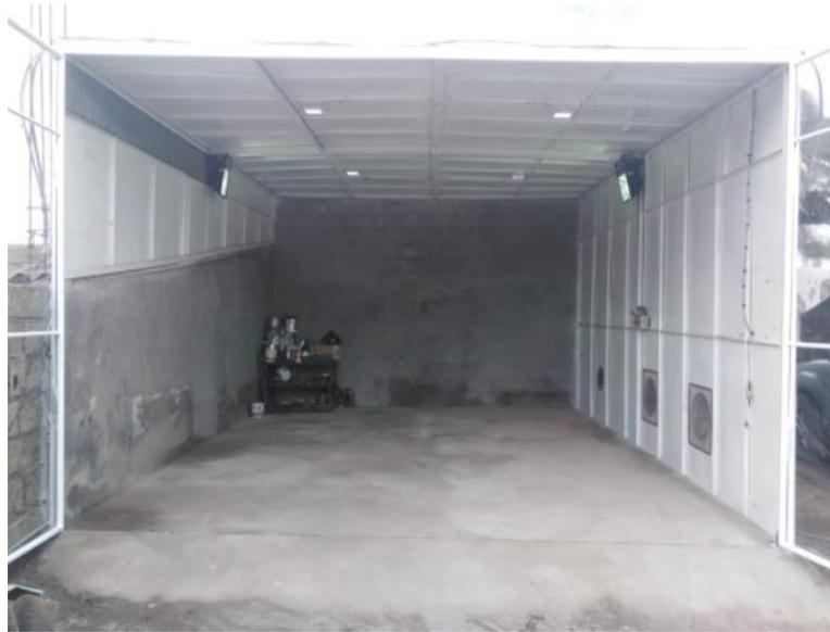
*Nota.* La figura indica la instalación de las luminarias verticales, para la correcta distribución de la luz en todo el espacio correspondiente a la cámara de pintura.
