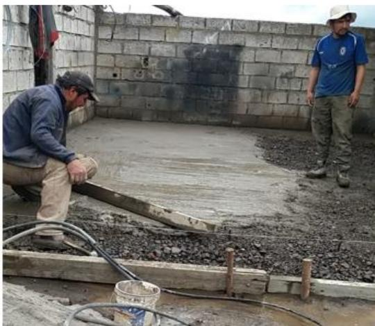
*Nota.* La figura muestra el concreto en proceso de fundición con un espesor de 5 centímetros.
