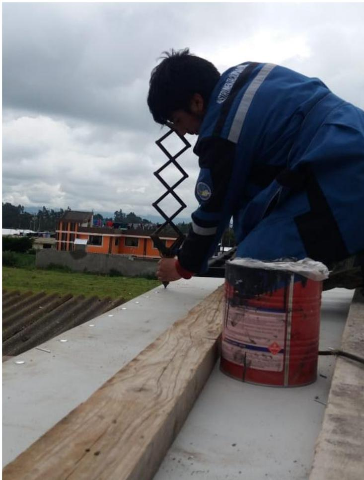
*Nota.* La figura muestra la sujeción del material aislante mediante la utilización de remaches.
