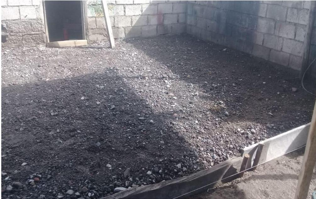
*Nota.* En la figura se muestra la ubicación del material como es piedra y ripio, para la nivelación de la superficie.
