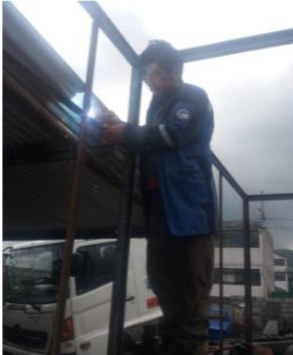
*Nota.* La figura muestra el proceso de ensamblaje y soldadura de la materia prima correspondiente al marco estructural.
