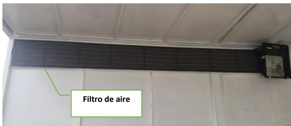
*Nota.* La figura indica la ubicación del filtro de aire, este consta de una malla electrosoldada, una esponja y algodón.
