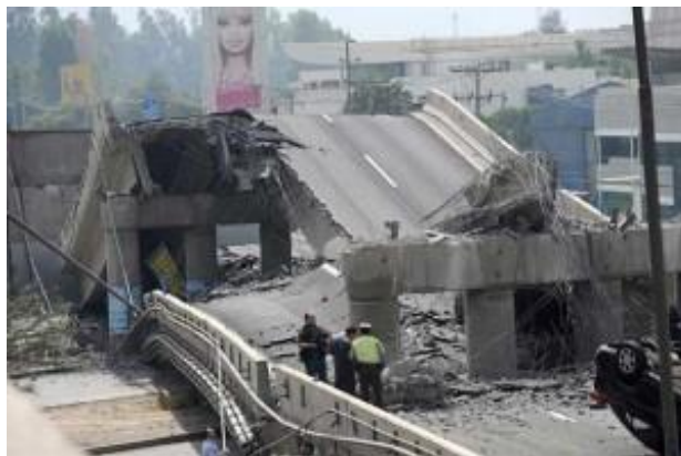
Fig.3.9.Colapso (Puente Talcahuano)
