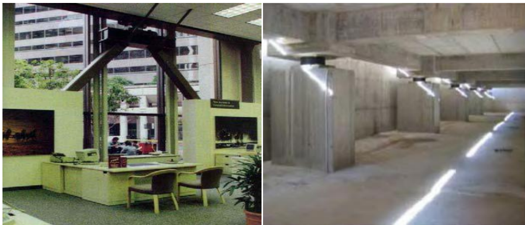
Fig. 2.1 Estructura con disipadores sísmicos Fig. 2.2 Estructura con aisladores sísmicos (Edificio La Reforma # 476 México) (Edificio Escuela de Ingeniería de la UC Chile)
