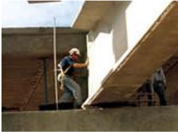
Fig. 3.4 Colocación del neopreno sobre estribo de puente.
