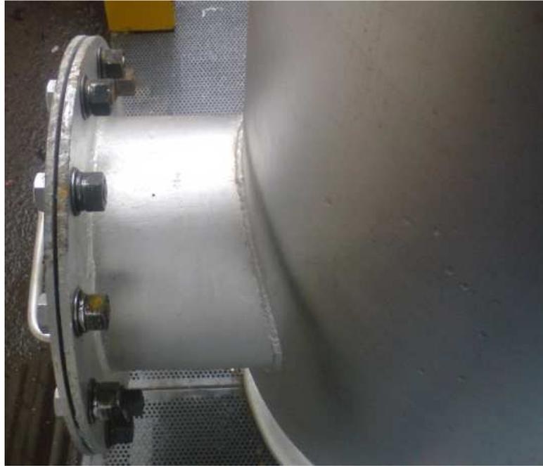
**Figura 4. 7 Brida para mantenimiento**
