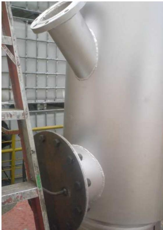
**Figura 4.11 Instalación de las tapas para las bridas en el calentador**
