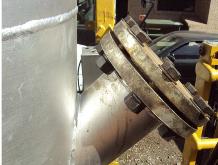
**Figura 4. 12 Brida para ingreso de efluentes contaminados<sup>68</sup>**
