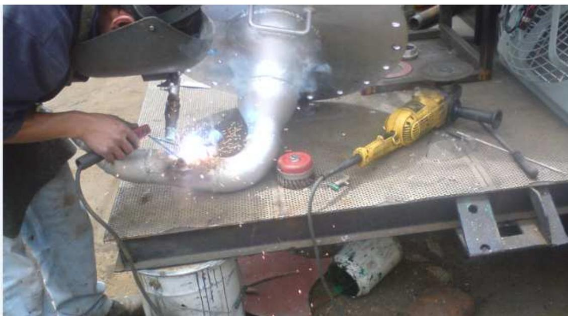
Figura 4. 9 Soldadura sección para la instalación de manómetro<sup>66</sup>
