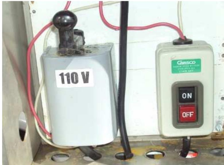
Figura 4.26 Panel de control de la bomba y deflector<sup>80</sup>
