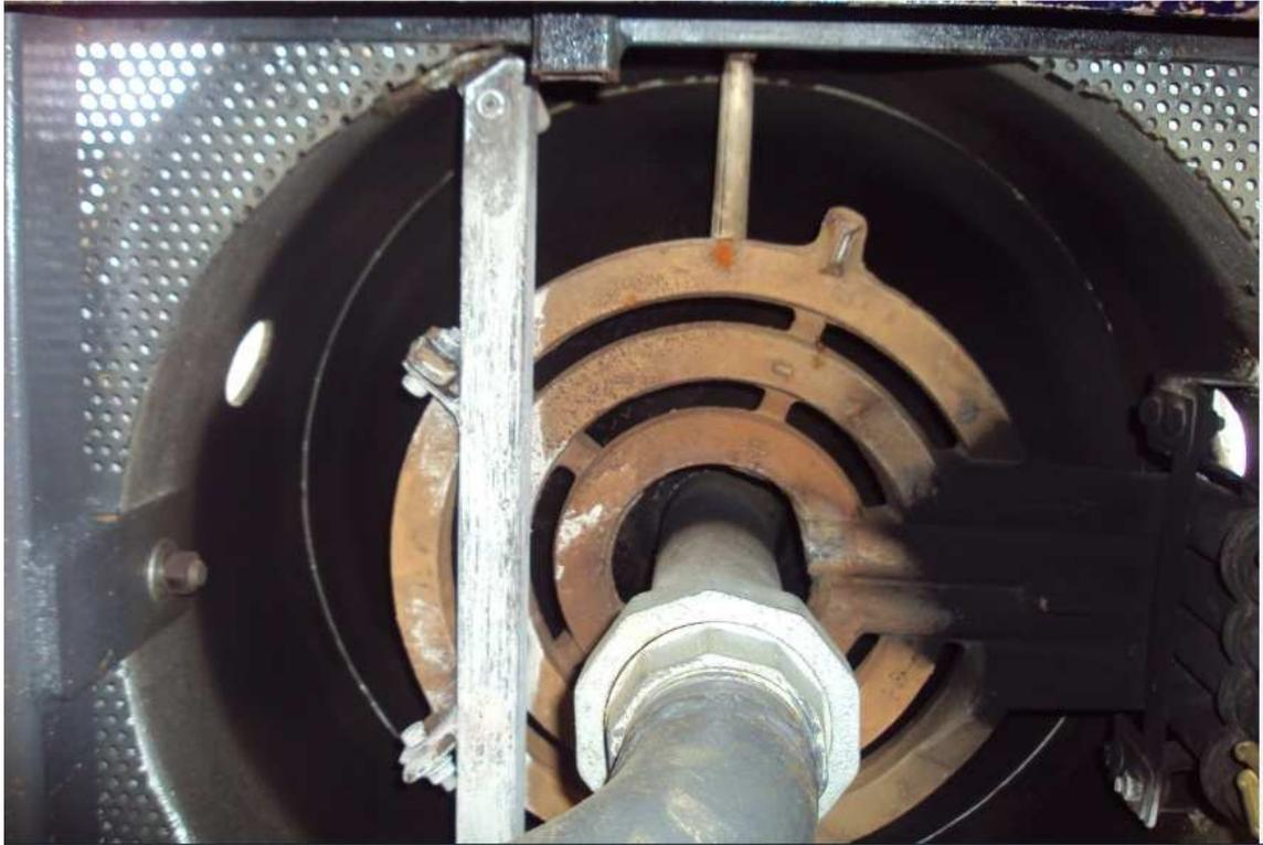
Figura 4.31 Hornillas ubicadas bajo el calentador<sup>85</sup>
