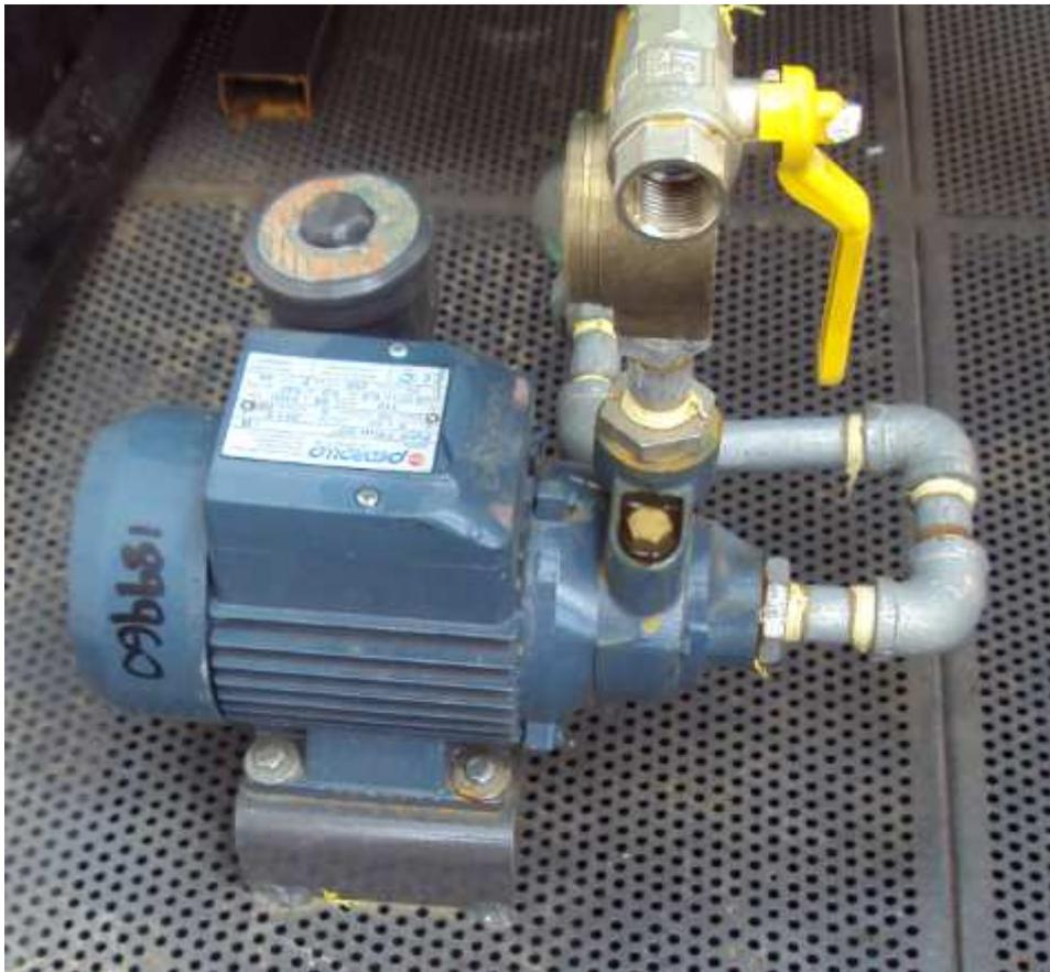
Figura 4.24 Bomba eléctrica Pedrollo<sup>78</sup>
