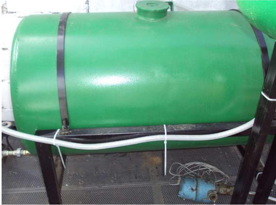
Figura 4.22 Tanque de reserva de agua<sup>76</sup>
