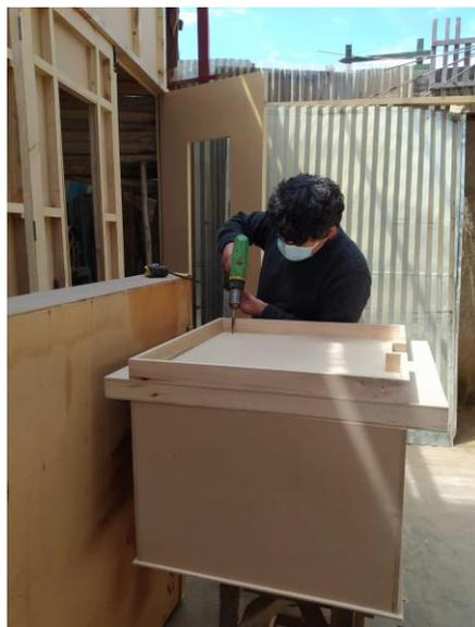
*Nota:* La figura anterior muestra la unión de las paredes de tabla con tornillos para una mayor sujeción de la estructura de la maqueta.
