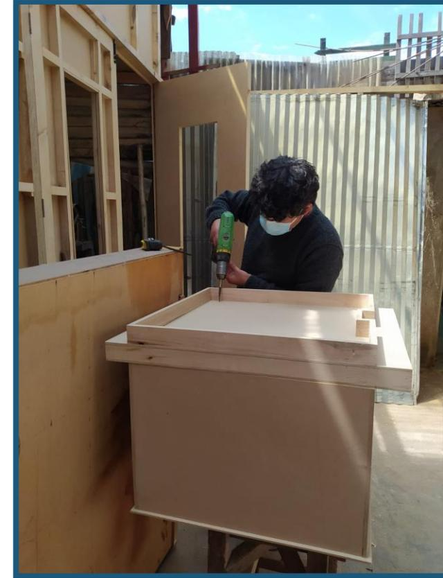
Unión de las paredes de tabla con tornillos para una mayor sujeción de la estructura de la maqueta.
