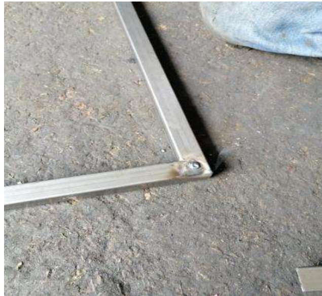
Figura 95 Apreciación del cordón de soldadura
