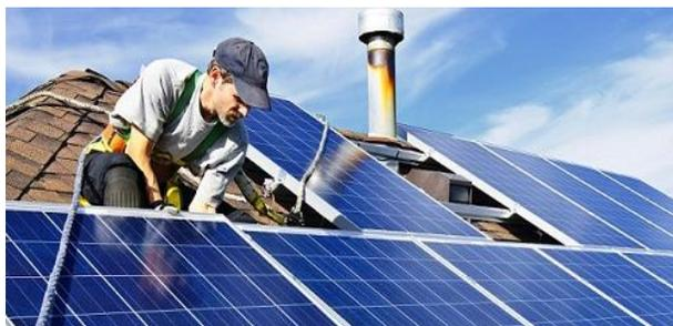
*Nota:* En la siguiente imagen muestra los paneles solares de celdas monocristalinas tienen una mayor eficiencia en condiciones estables. Tomado de (Delta Volt SAC).
