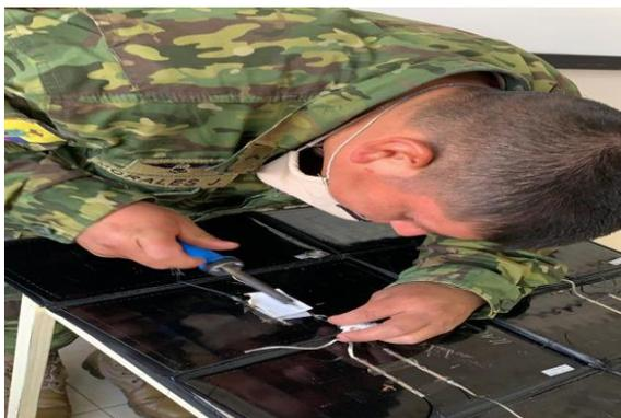
*Nota:* En la siguiente imagen se puede observar como se encuentra realizada las respectivas conexiones eléctricas con los paneles solares policristalinos. Tomada de (Job Morales, 2021).
