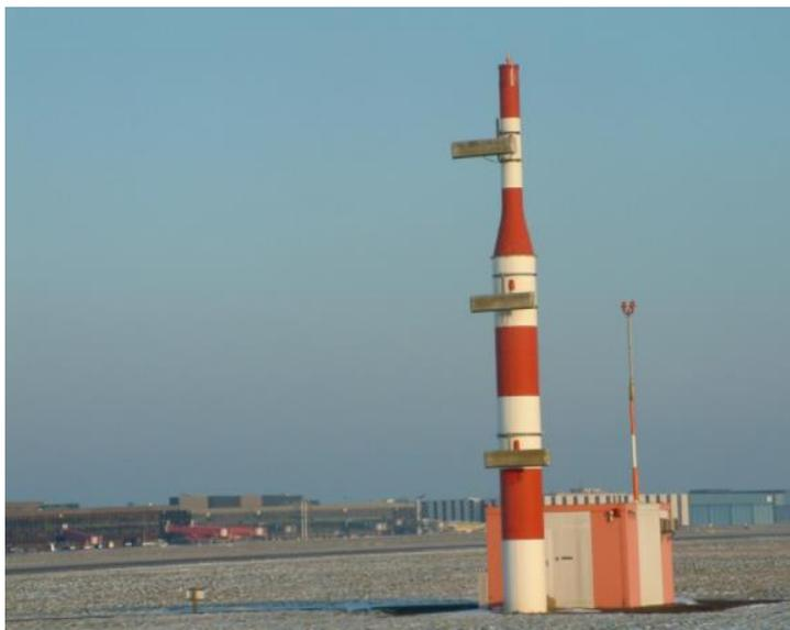
*Nota:* La figura muestra una antena localizadora al final de la pista. Tomado de (Pinto, s.f.).
