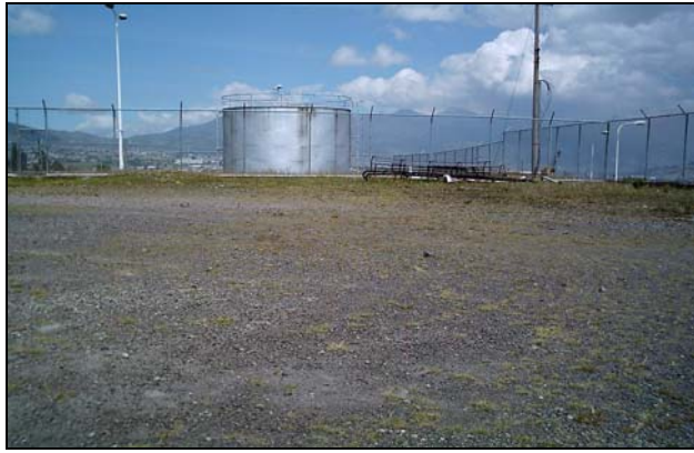
Foto 1.1: Tanque de uso diario.
