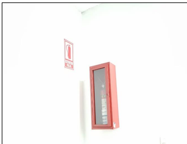
Figura 32 Extintor PQS segundo piso
