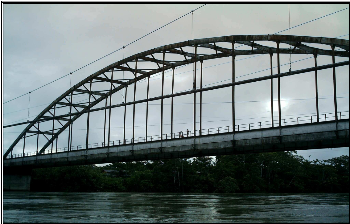
Foto 2.1 Estación en el puente de San Sebastián sobre el río
