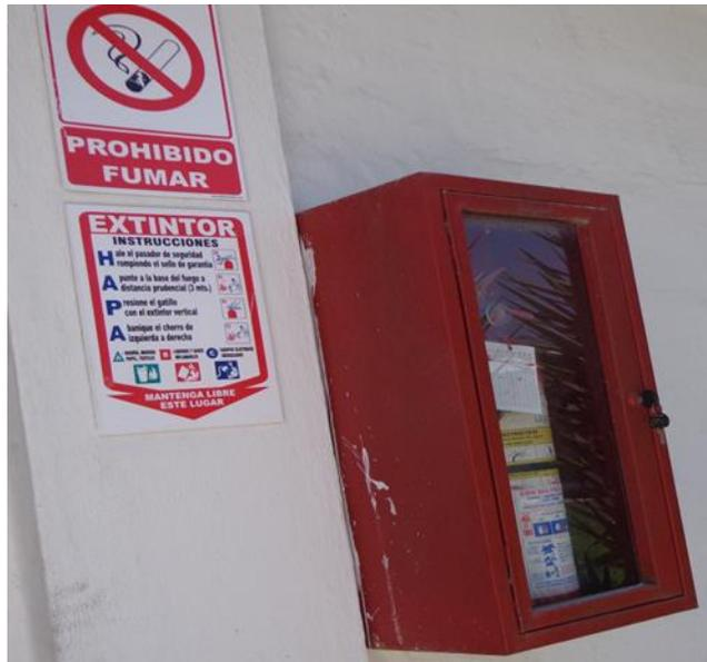
**Figura 3.32.** Normas de Seguridad Extintor
