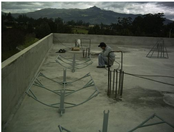
Figura 6.55. Proceso de pintura de la estructura soporte.
