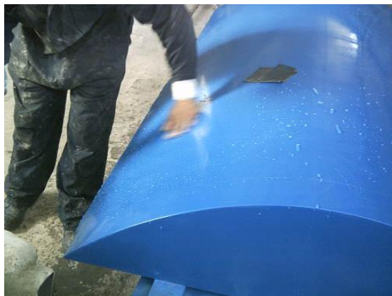
Figura 6.27. Colocación del desmoldante PVA.
