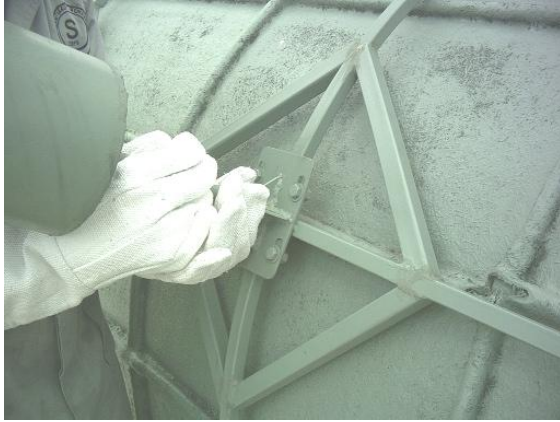
Figura 7.18. Desplazamiento del soporte para contrapeso.
