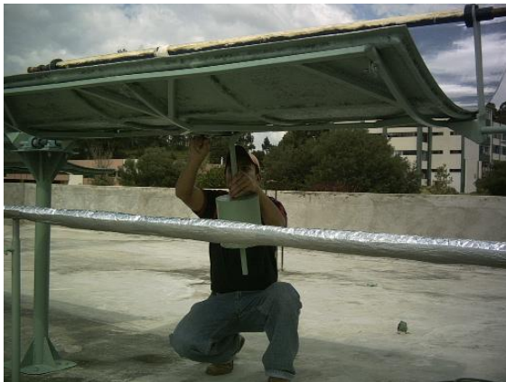
Figura 7.10. Ubicación y ajustaje de los contrapesos.
