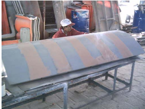
Figura 6.5. Arreglo de imperfecciones en la superficie del molde.
