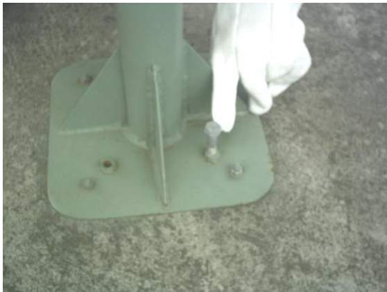
Figura 7.15. Pernos de nivelación.
