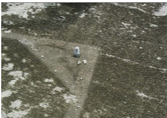
Figura 7.3. Colocación de los pernos de anclaje.
