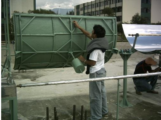
Figura 7.9. Ensamblaje de los contrapesos y soportes para contrapesos.
