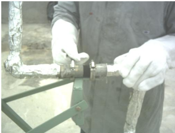
Figura 7.22. Colocación de las abrazaderas.
