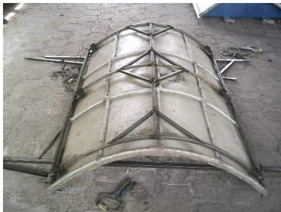
Figura 6.54. Construcción de la estructura soporte.
