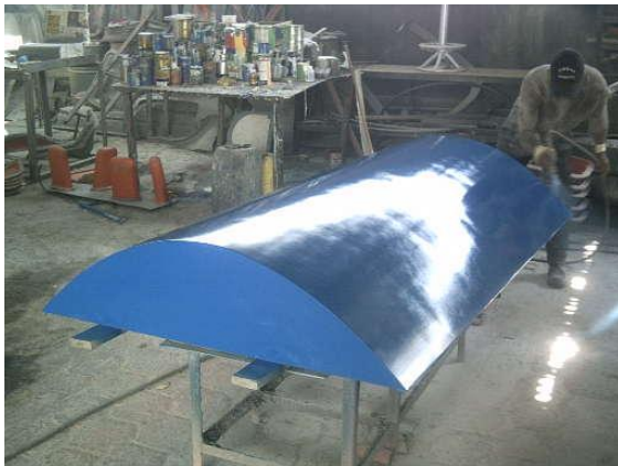
Figura 6.13. Proceso de pintura de la superficie del molde.
