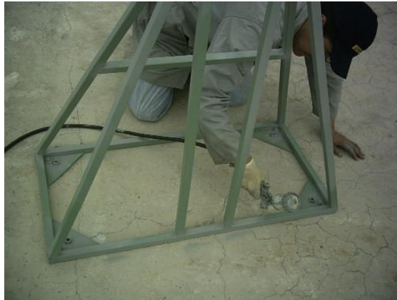
Figura 7.4. Fijación de las bases.
