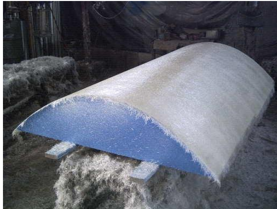
Figura 6.38. Colocación de la fibra de vidrio.
