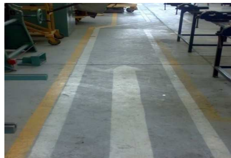
Señalización de tránsito
