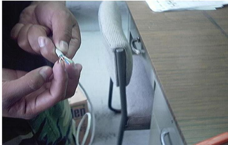
**14. COLOCACION DE LOS PARES DE HILOS EN EL CONECTOR**
