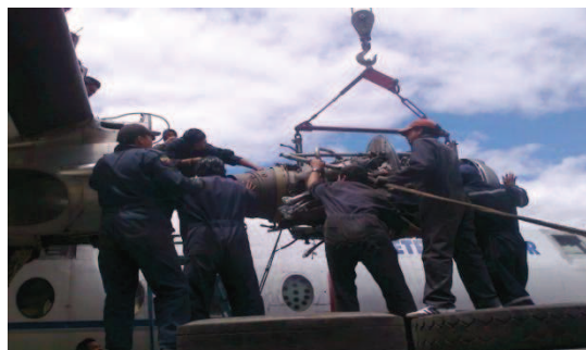
Fig.3.13 Instalación del motor
