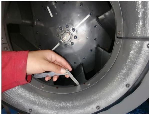
*Nota.* La figura muestra la verificación del espacio que existe entre el Fanwheel y el Scroll.
