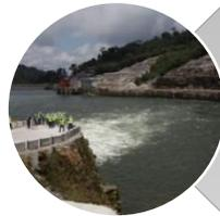
**Embalse compensador:** Mediante el túnel de conducción de 24.83 km de longitud el agua es embalsada a 620 m sobre la casa de máquinas.
