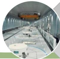
**Casa de máquinas:** Con una capacidad instalada de 1500 MW distribuido en 8 unidades tipo Peltón de 187.5MW cada una.
