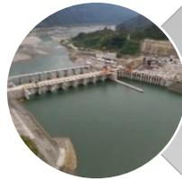
**Captación Agua:** Es conformada por una presa de hormigón de 31.8 m de altura, un vertedero de 160 m de ancho y 8 cámaras de desarenadores que permiten transportar el caudal del río Coca.
