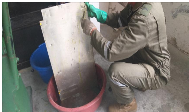
Tratamiento anticorrosivo a la lámina de aluminio
