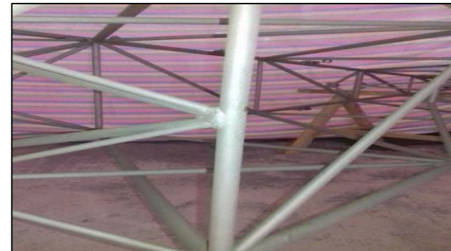
Primera capa de pintura
