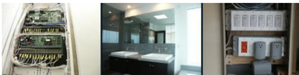
Figura. 3.9. De Izquierda a derecha: Omni Pro II con 64 zonas de protección escondido detrás de una pared falsa, Baño máster ultra moderno con control inteligente de luces y servicios, sistema auxiliar de soporte acondicionador de línea para transmisión de datos vía PLC
