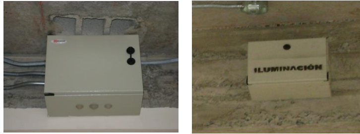
Figura 5.13. Cajas Inmótica colocadas en obra civil
