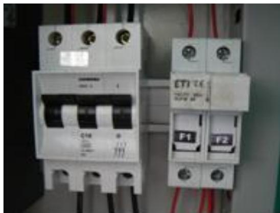
**Figura 2.26. Brakers y fusibles.**
