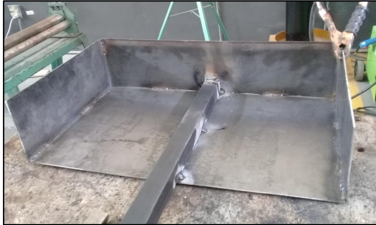
Figura 46 Suelda del Eje Principal con la Base
