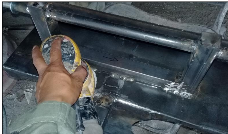
Figura 55 Lijada de la estructura
