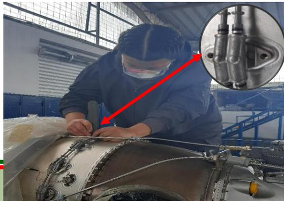
Extracción del inyector.
