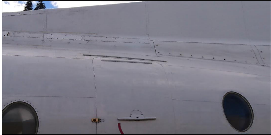
Figura 47 Inspección visual parte posterior
