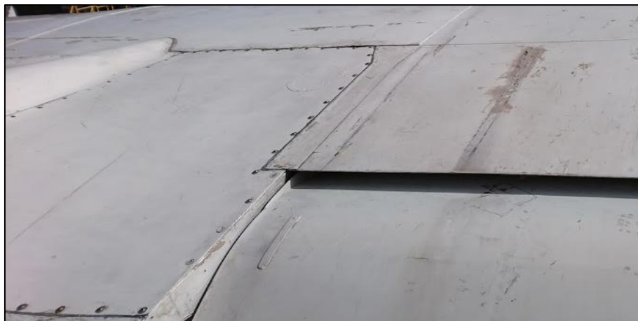
Figura 54 Instalación del equipo de seguridad.
