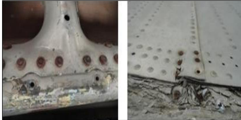
Figura 21 Tipos de corrosión en la industria aeronáutica
