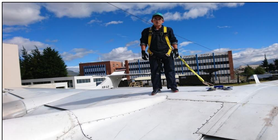
Figura 52 Instalación del equipo de seguridad.
