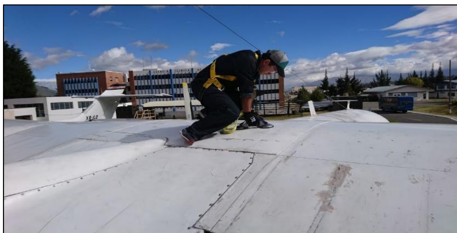
Figura 51 Instalación del equipo de seguridad.
