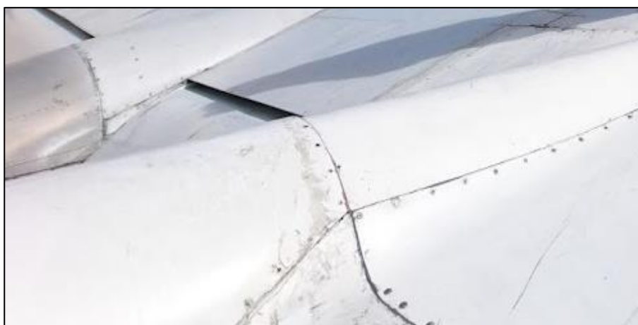
Figura 42 Inspección visual directa.
