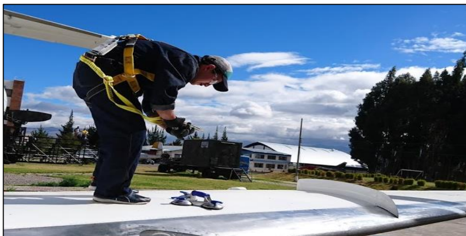
Figura 38 Implementación del equipo de protección.
