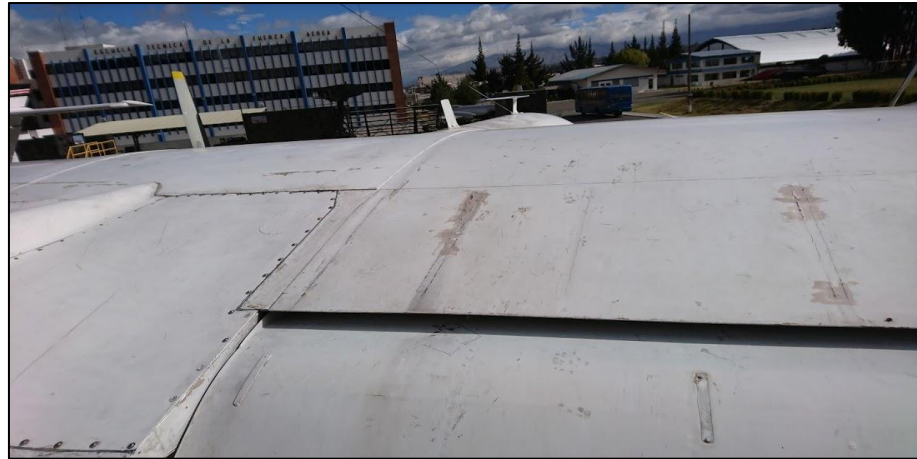
Figura 43 Inspección visual del ala
