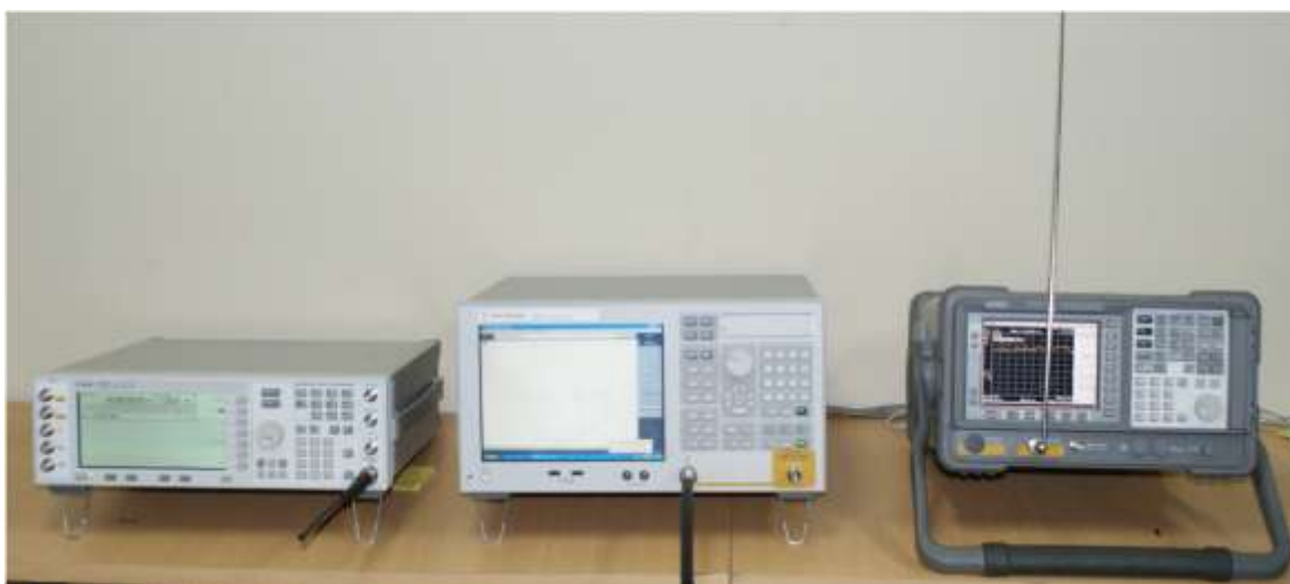
Figura. 4.20. Pruebas de Integración y Funcionamiento de los Equipos 20
