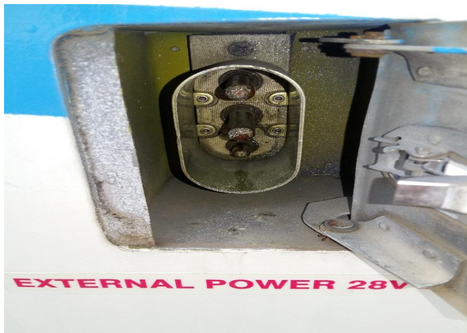
Figura 28 Puerto de conexión planta externa 28 V
