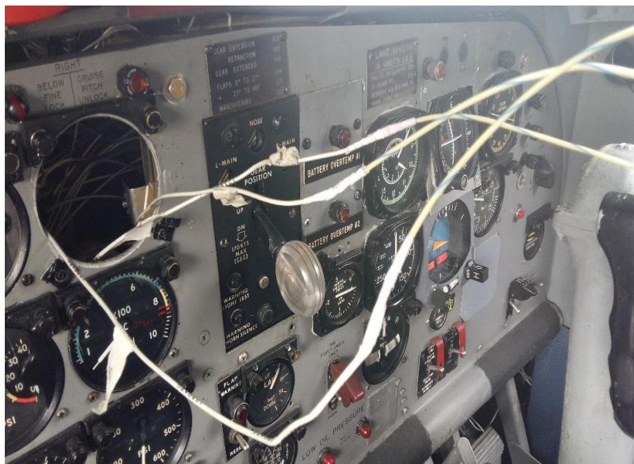
Figura 35 Conexión eléctrica del cableado en cabina
