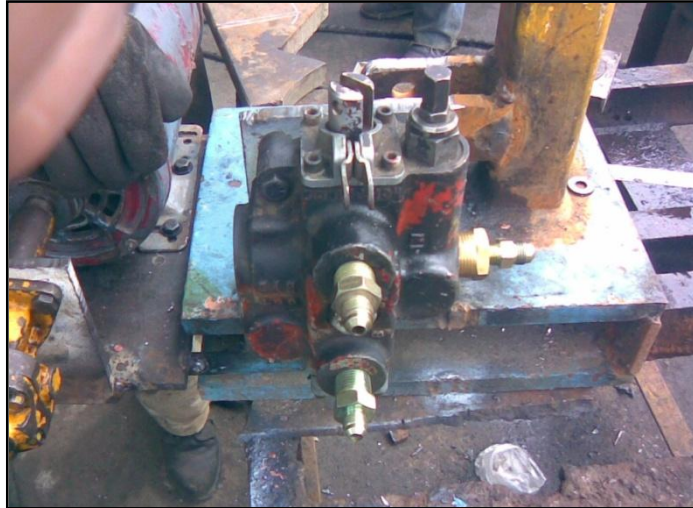
Figura 4.12 Montaje de elementos Hidráulicos.
