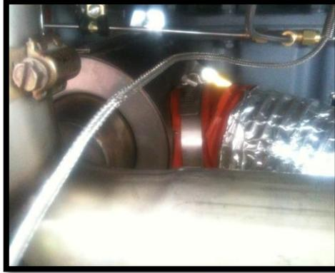
**FIGURA 72 Conexión ducto flexible a la cubierta delantera**
