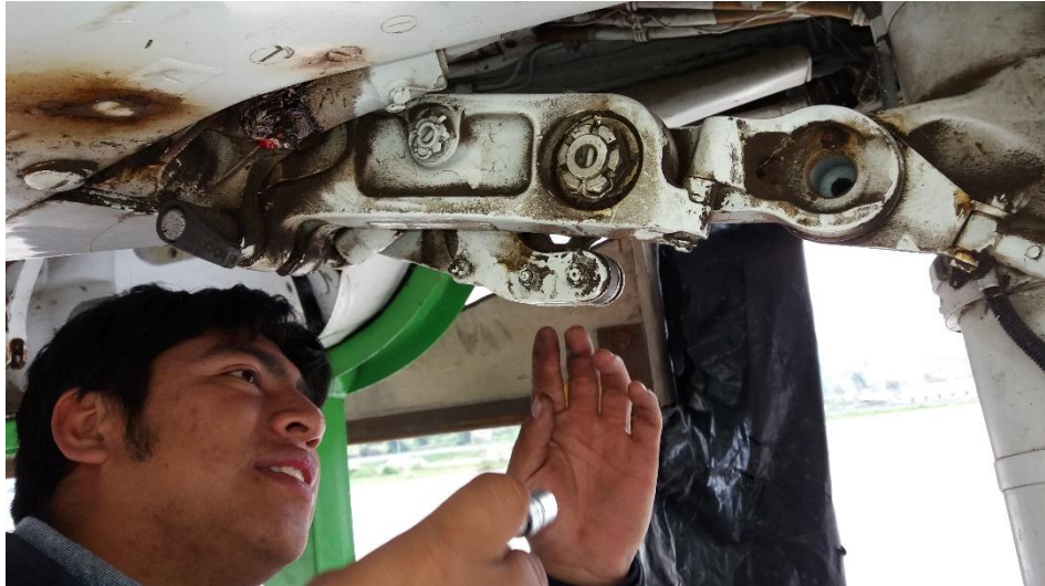
Figura 50 Desinstalación de los pernos del brazo articulado del tren de aterrizaje principal
