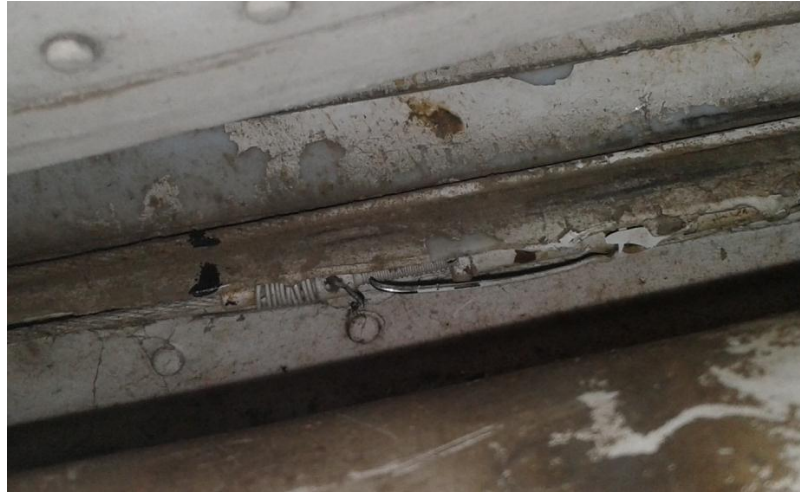
Figura 45 Corte del alambre de freno de los turnbuckles de los cables
