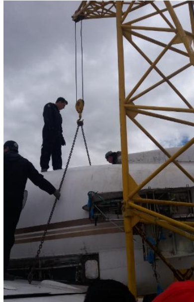
Figura 55 Acoplamiento del tecele a la cadena
