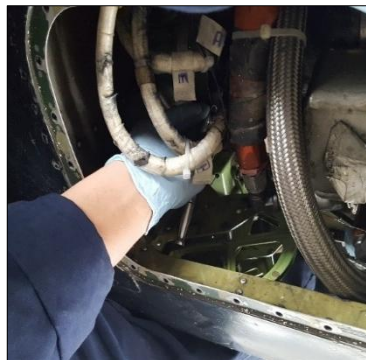
Figura 25 Cables conectados al generador
