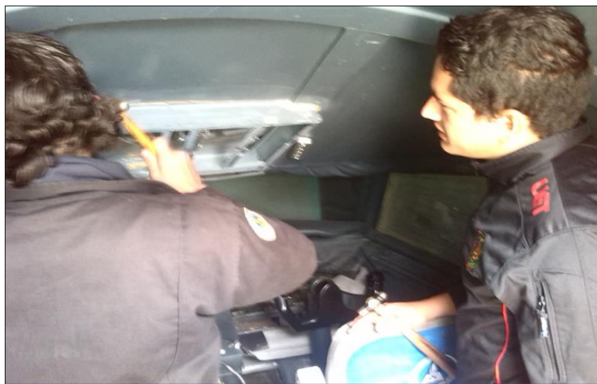
Figura 34 Desmontaje de marco externo
