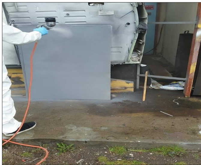
Figura 51 Pintura de los paneles
