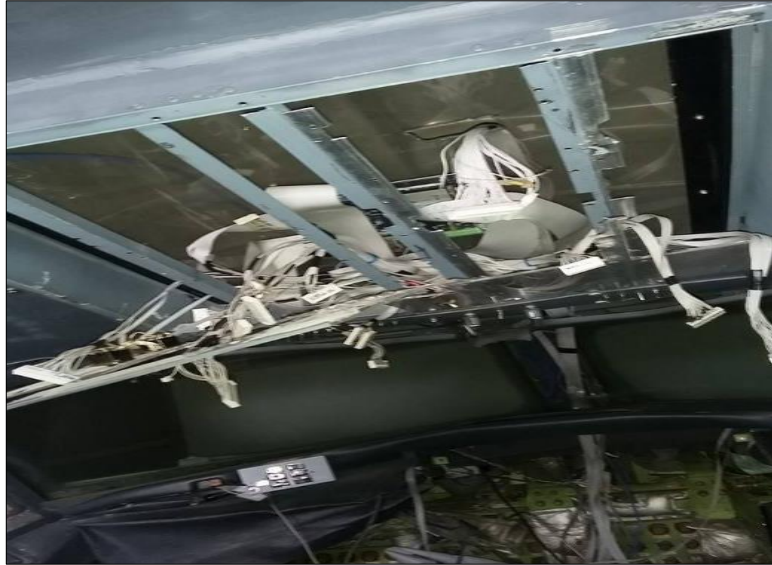
Figura 35 Desmontaje de paneles
