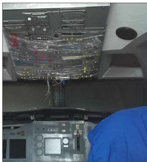
Figura 82 Montaje de los OVERHEAD
