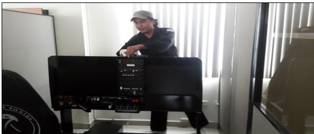
Figura 40. Instalación de los equipos.
