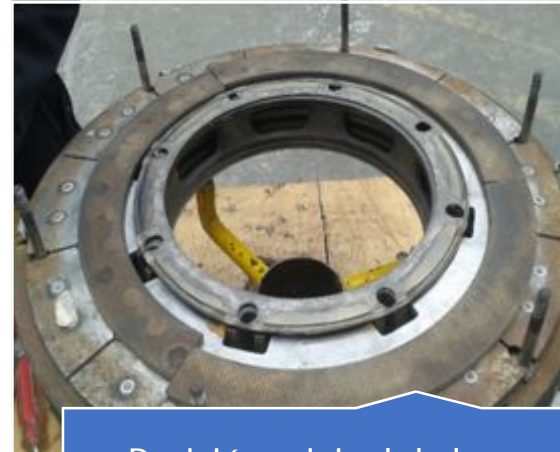
Posición original de los anillos de seguridad y apoyo
