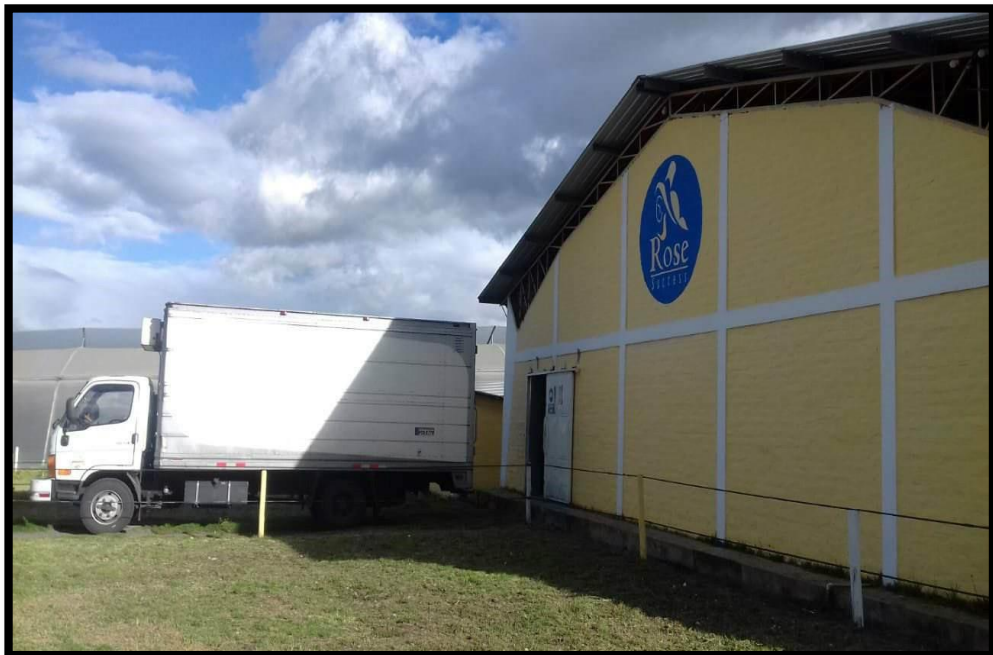
Inadecuada distribución del producto terminado en el medio de transporte
