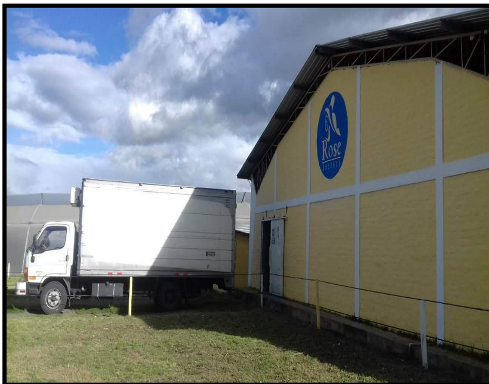
Figura 15 Zona de carga y descarga de pedidos
