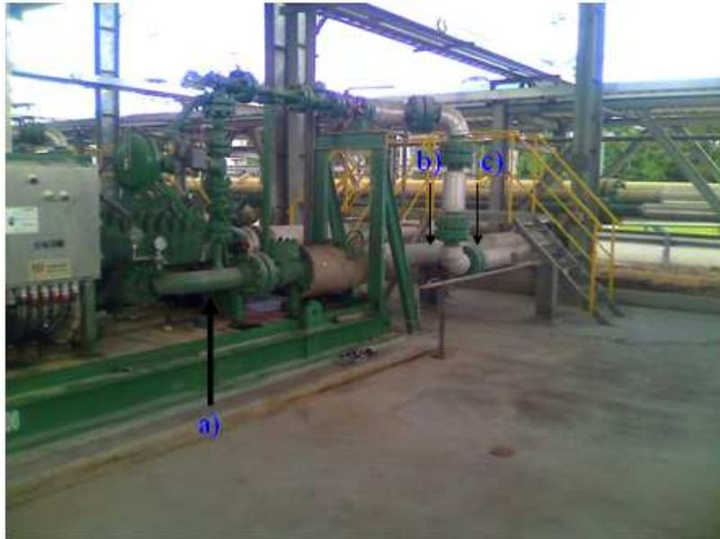
**Figura 4.8** a) tubería de descarga b) Ubicación de la válvula de control c) Ubicación del medidor digital de caudal y Presión
