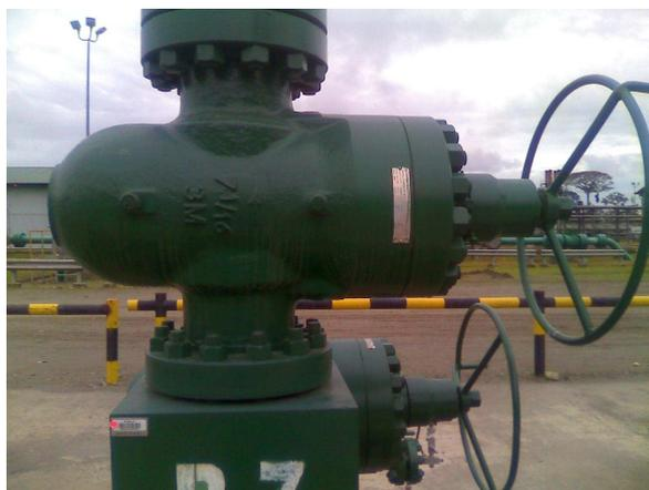
**Figura 3.34** Conjunto de válvulas de compuerta “Árbol de navidad”
