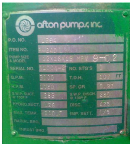
**Figura 3.6** Placa de una bomba Booster 2000 GPM
