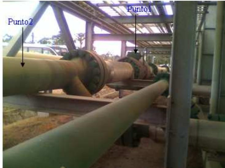
**Figura 4.1** Válvula de bola de 16" y puntos de desplazamiento
