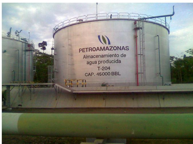
**Figura 3.1** Tanque de almacenamiento de agua de formación T-204
