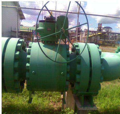
**Figura 3.31** Válvula de bola con actuador y accionamiento mecánico
