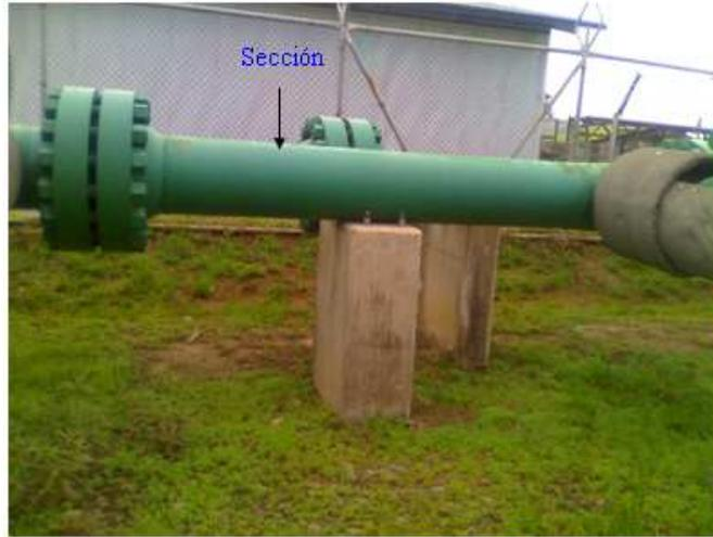
**Figura 4.5** Sección de la tubería común entre la válvula de choque B-07 y B-05
