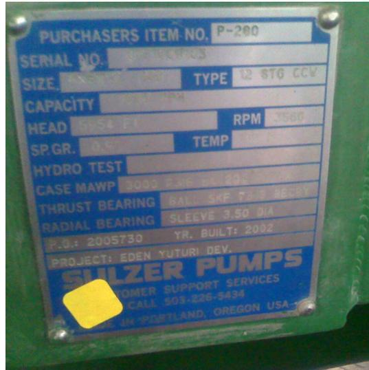
Figura 3.17 Placa de una bomba Disposal
