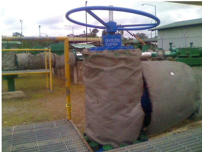
**Figura 3.35** Válvula de choque B6 (nueva cambiada el 8 de mayo del 2010)
