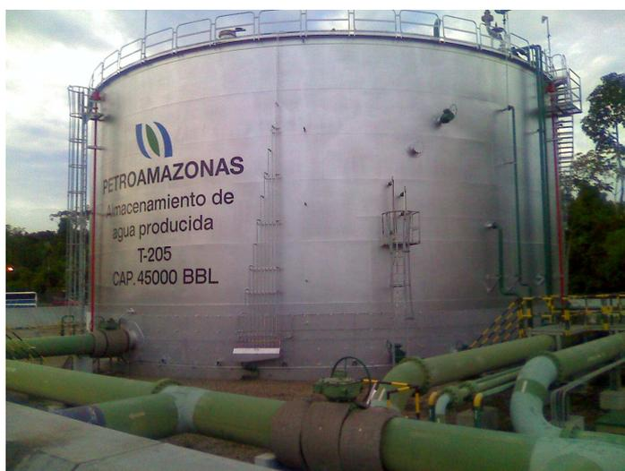
**Figura 3.2** Tanque de almacenamiento de agua de formación T-205
