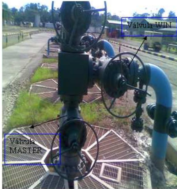
**Figura 3.36** Conjunto de válvulas de compuerta “Árbol de navidad”
